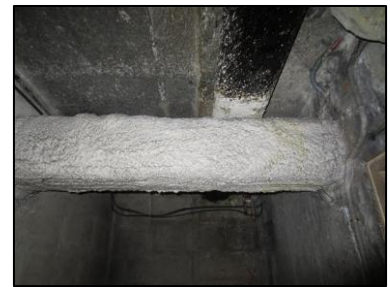
Photo N° 929 AMIANTE CIMENT -- COULOIRS -1 Gainses & coffres horizontaux Ventilation haute (Fibres-ciment)
